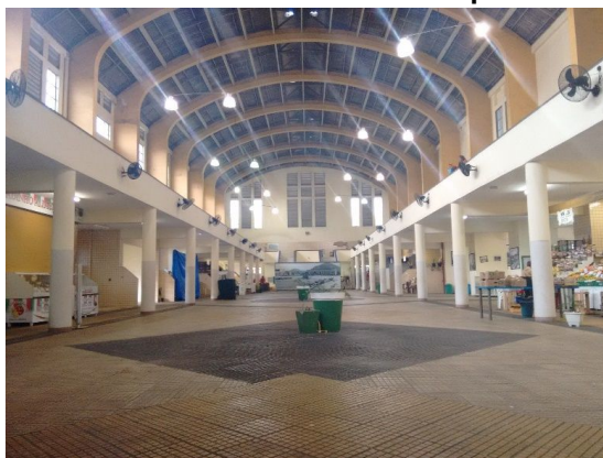
Figura 3: Interior del Mercado Municipal de Santos
