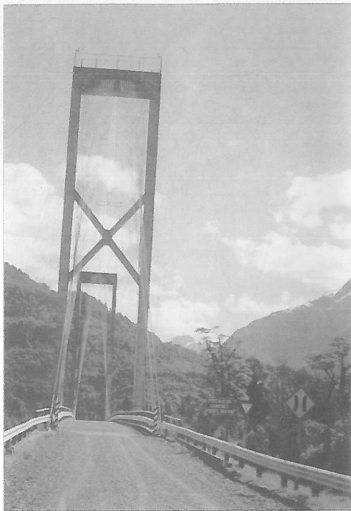
Puente en el extremo norte de la Carretera Austral - Chile
