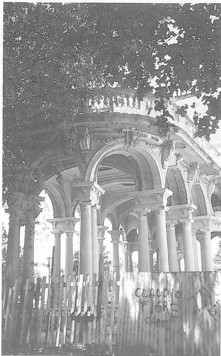
Columnata compuesta del Tigre Club (en reacondicionamiento), ejemplo de la Belle Epoque
