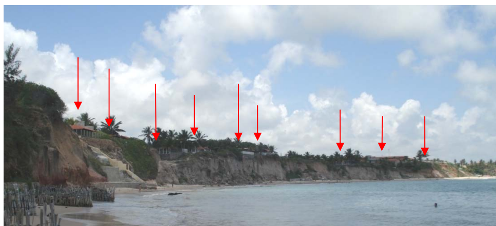
Foto 3: Construcciones irregulares – borda de falésia, Carapibus
