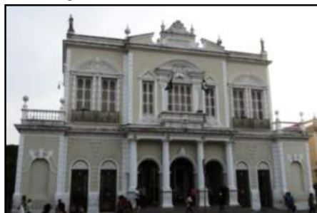
Figura 1: Vista externa del TJA
