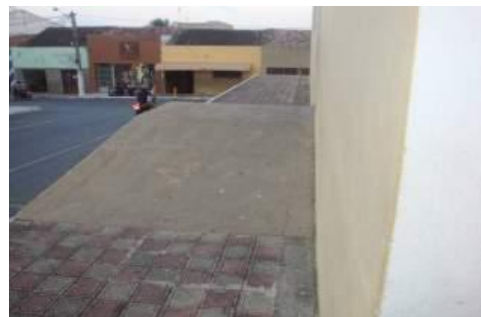
Figura 22: Rampa en la Iglesia de Santa Rita de Cássia
