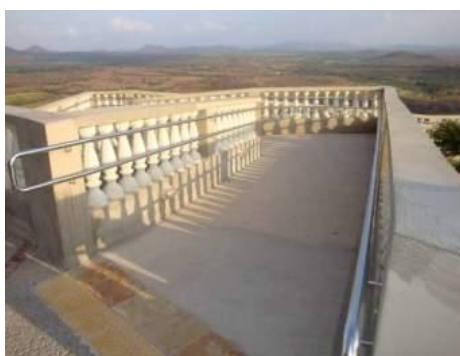
Figura 27: Rampa de acceso al piso superior
