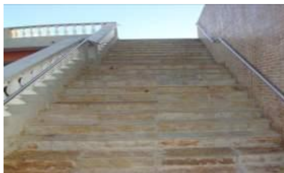
Figura 30: Escalera hacia el piso inferior
