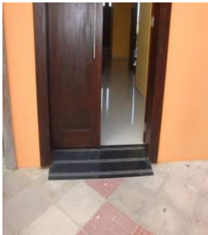
Figura 28: Rampa de acceso a la sala de promesas
